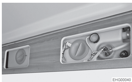
Fig. 69 Depósito de agua
